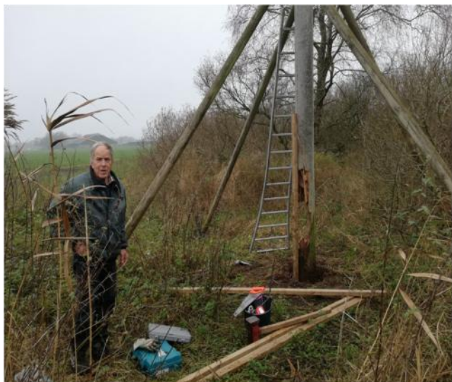
Steunpalen en spalken waren nodig!
